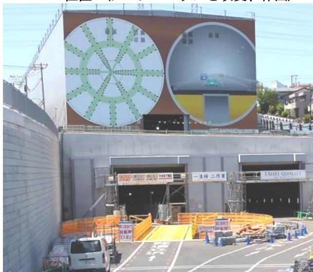
左上図形:シールド径 右上図形:トンネル径 左手前車両と比較ください。
