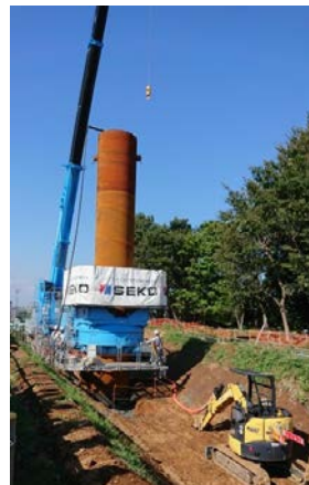
圧入中の鋼管
