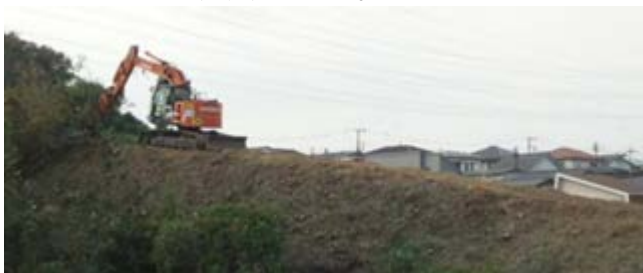
(重機による整地作業)
