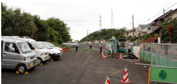
(神戸橋遊水地西側の工事準備状況)
