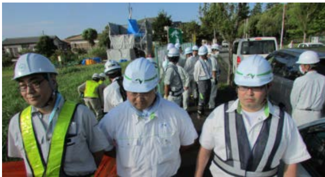
(道路を不法占拠し、工事を強行 2014.09.25)
