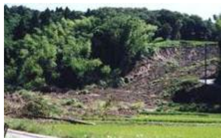
水田の地滑りを示す写真。周辺の凝灰質砂岩は、著しく脆くなっている。 (活断層研究センター)
