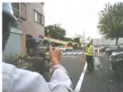
地表面沈下測定
