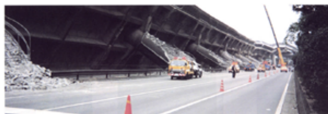
写真11-26.11.27 阪神高速3号神戸線深江付近 ビルトアップ式の橋梁の倒壊
