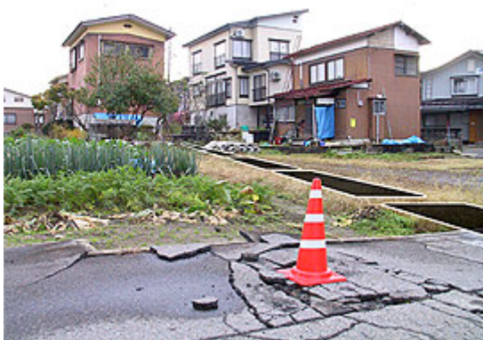
図 13 中越地震によって、十日町市街地で、ほくほく線開削トンネル直上の家屋が傾いた。埋め戻し土が揺すり沈下を起こしたとされる。
