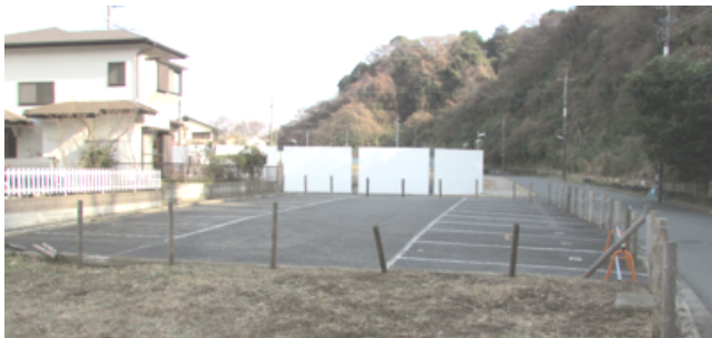
(杭と堀に囲まれた桂台地区道路予定地)
