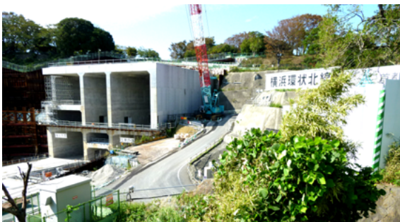
(環状北線工事現場)
