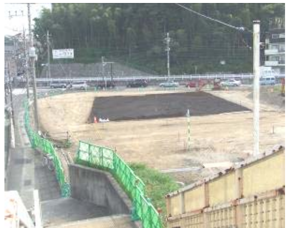
2010/10/20(歩道橋上から)
