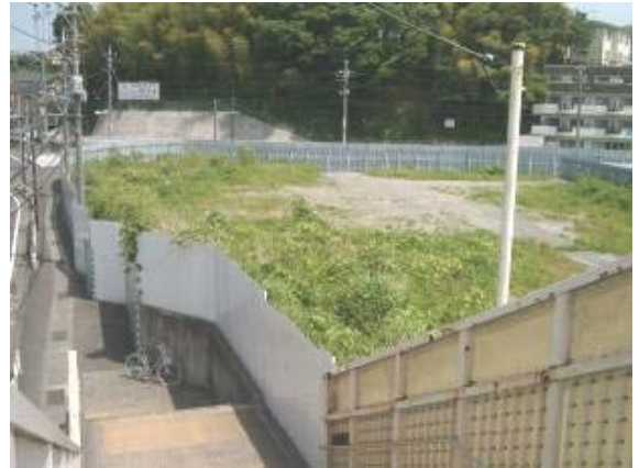
2007/05/23(歩道橋上から)
